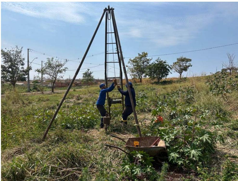
Foto 03 – Perfuração do furo SP-02. Foto Alexandre.
