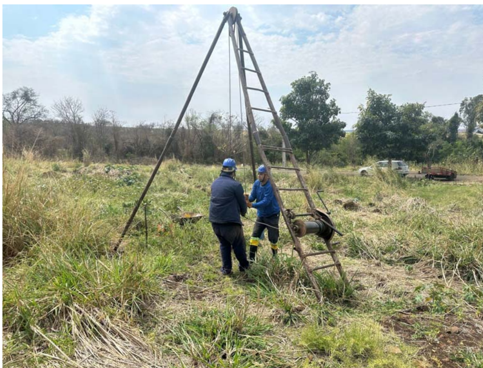
Foto 01 – Perfuração do furo SP-01. Foto Alexandre.
