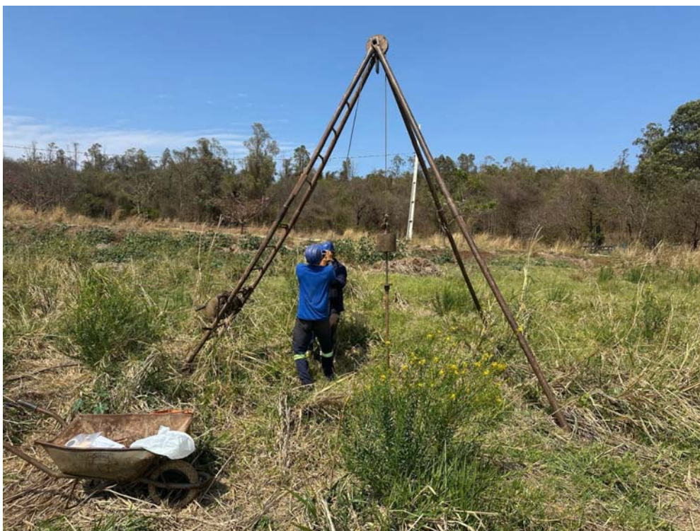
Foto 03 – Perfuração do furo SP-03. Foto Alexandre.
